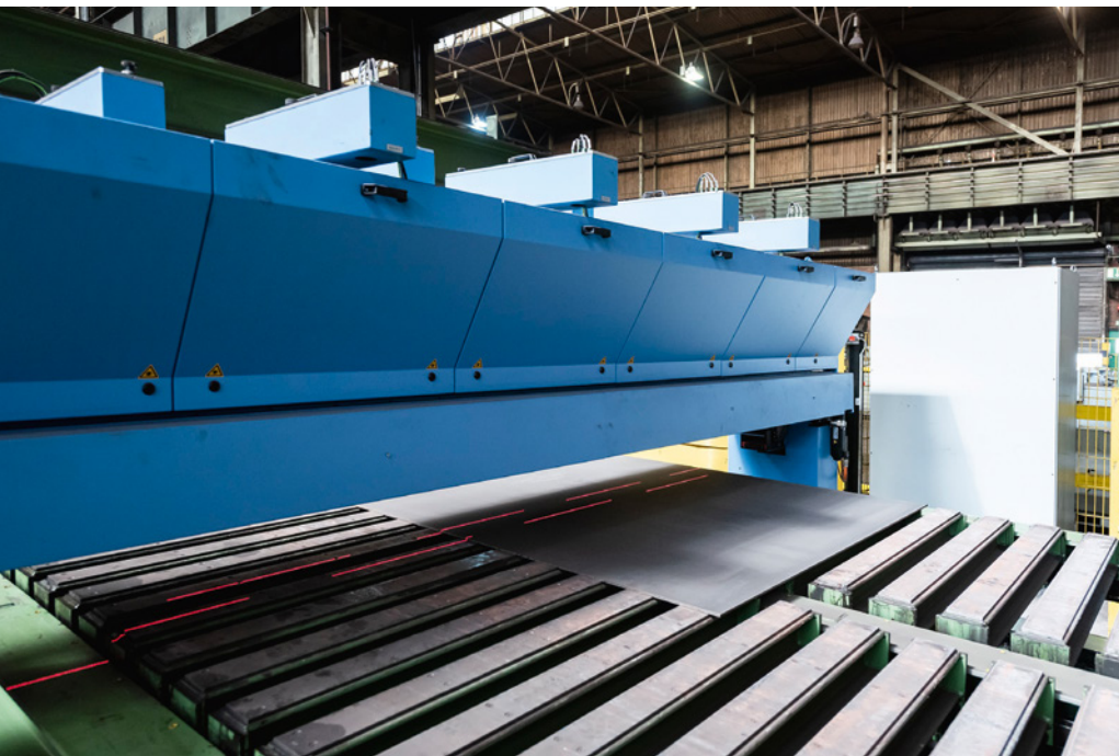
Die Ebenheitsmessanlage ist am Ende der Veredelungslinie hinter der Entzunderungs- und Farbspritzanlage angeordnet (Bild: thyssenkrupp Steel Europe)
